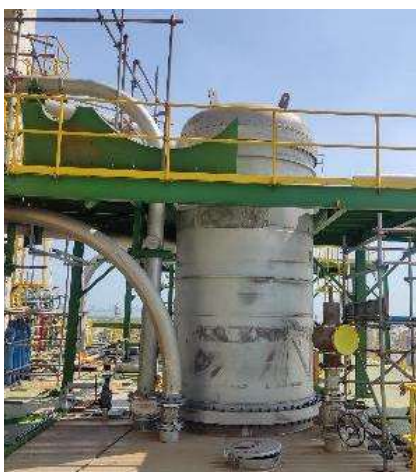
Hình 7. Thiết bị lọc túi vải
